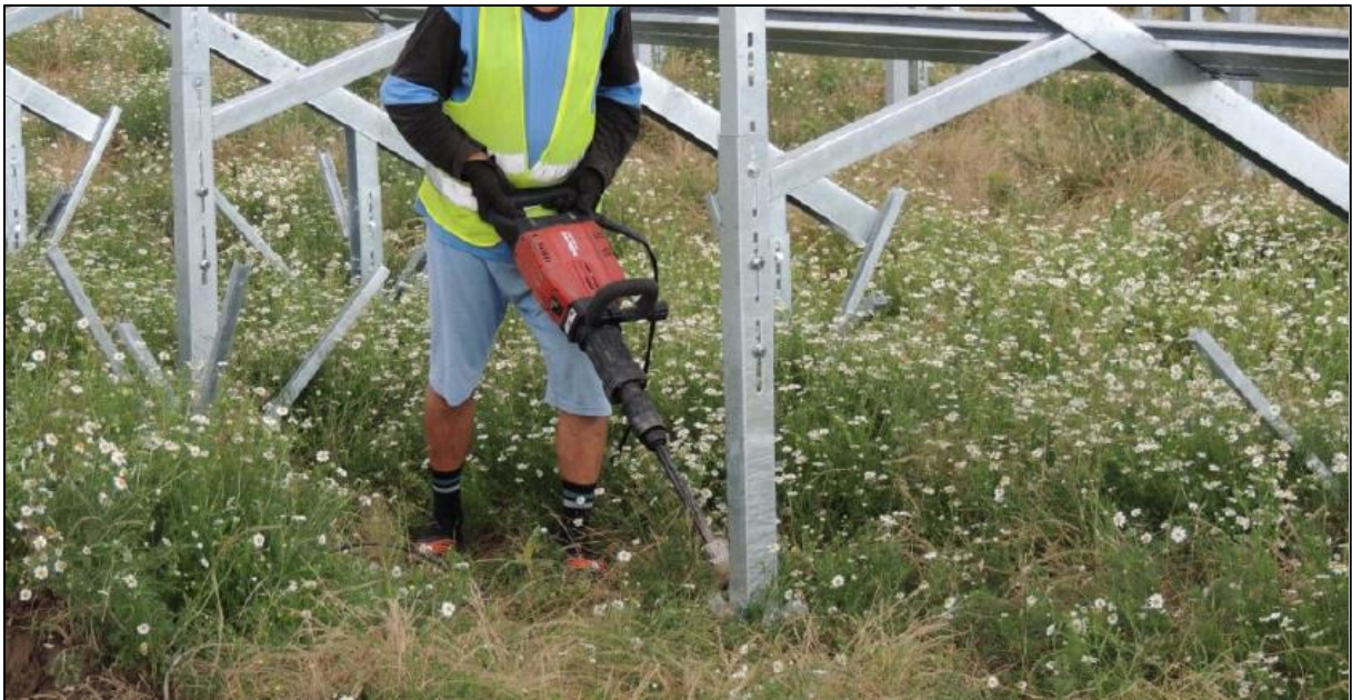
Joonis 3. Kinnistusvaiade maasse fikseerimine 8 .
